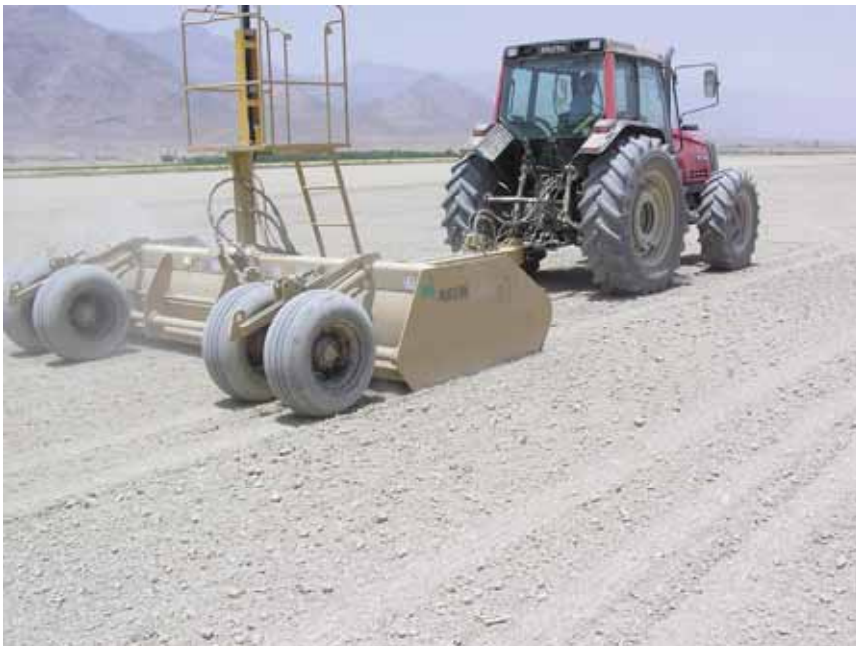
نگاره ۶- واحد تسطیح لولر لیزری رینولدز ساخت کشور آمریکا در حین اجرای عملیات تسطیح در منطقه سروستان.
