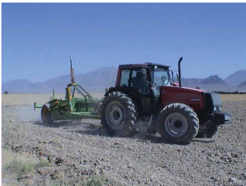
نگاره ۸- واحد تسطیح اسکریپر لیزری ساخت کشور استرالیا در حین اجرای عملیات تسطیح در منطقه سروستان.
