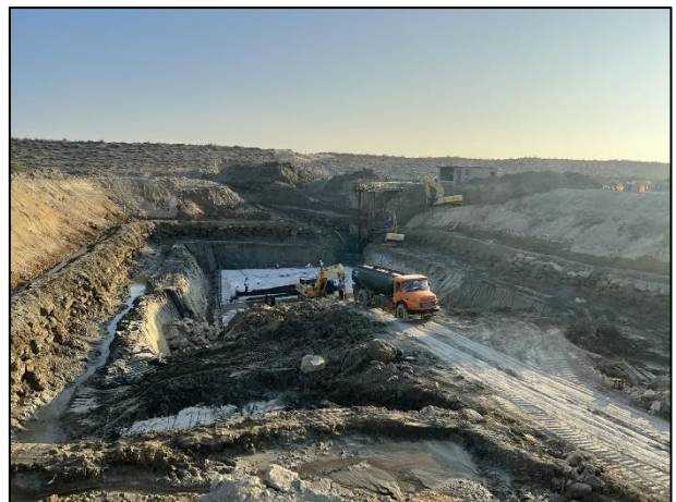
عملیات خاکبرداری قسمتی از کارخانه آب شیرین کن در مجاورت دریا
