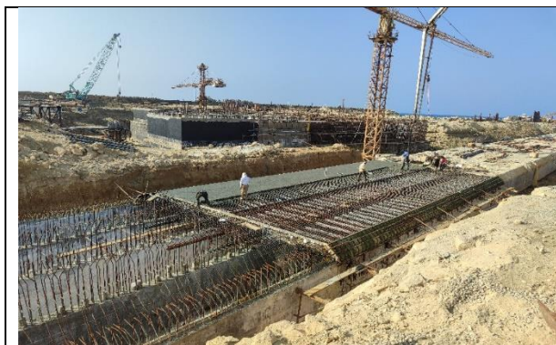
اجرای کالورت بتنی تاسیسات آبیگری که بعد از تکمیل، شناور شده و سپس نصب می شود
