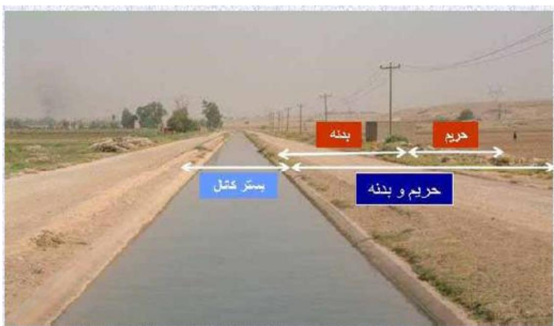
شکل ۳- نمایش مقطع کanal، بستر، بدنه و حrیم
