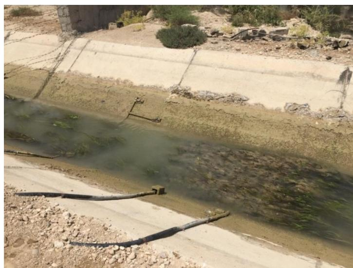
شکل‌های ۶ تا ۸- پوشیده شدن سنسورها از گل و لای و علف به دلیل عدم بهره برداری درست
