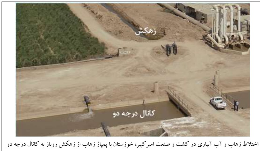
شکل ۱۱-۵- استفاده دوباره از زهاب به روش اختلاط در سطح بخشی از شبکه
