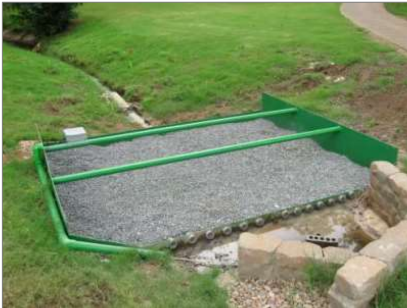
شکل ۴-۱۴ - نمونه‌ای از سازه فیلتر محصور برای جذب فسفر
