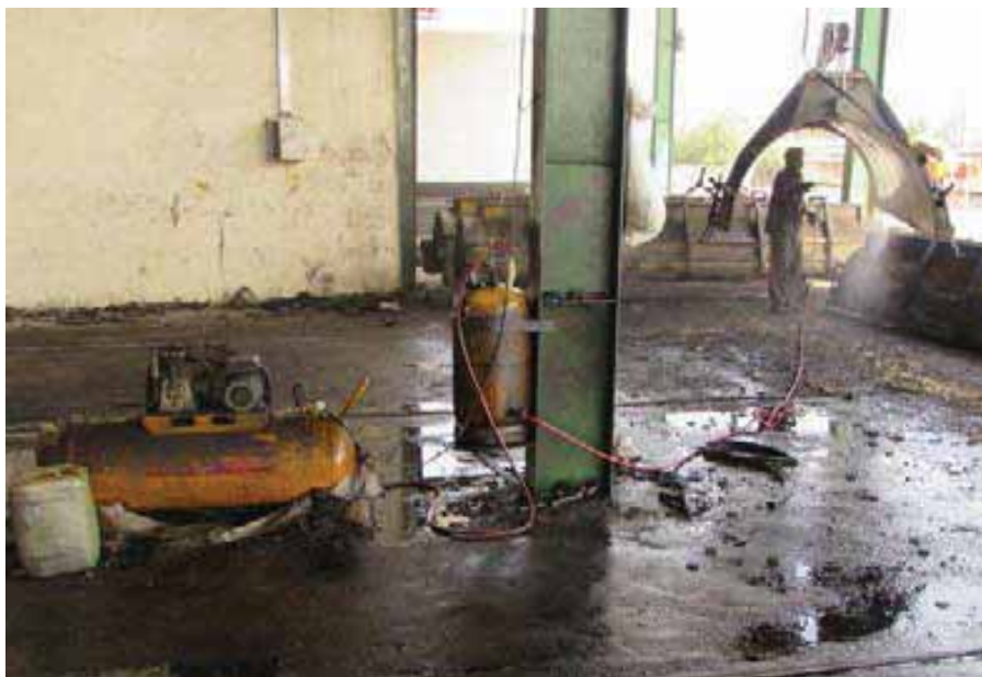
شکل (۳-۱): روغنکاری قالب بیرونی کانالت
