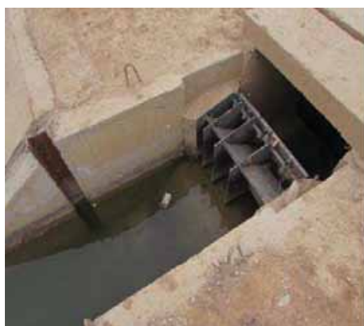
شکل (۶-۲) مشخصات و تصویر یک مدول نیرپیک دوسپره
