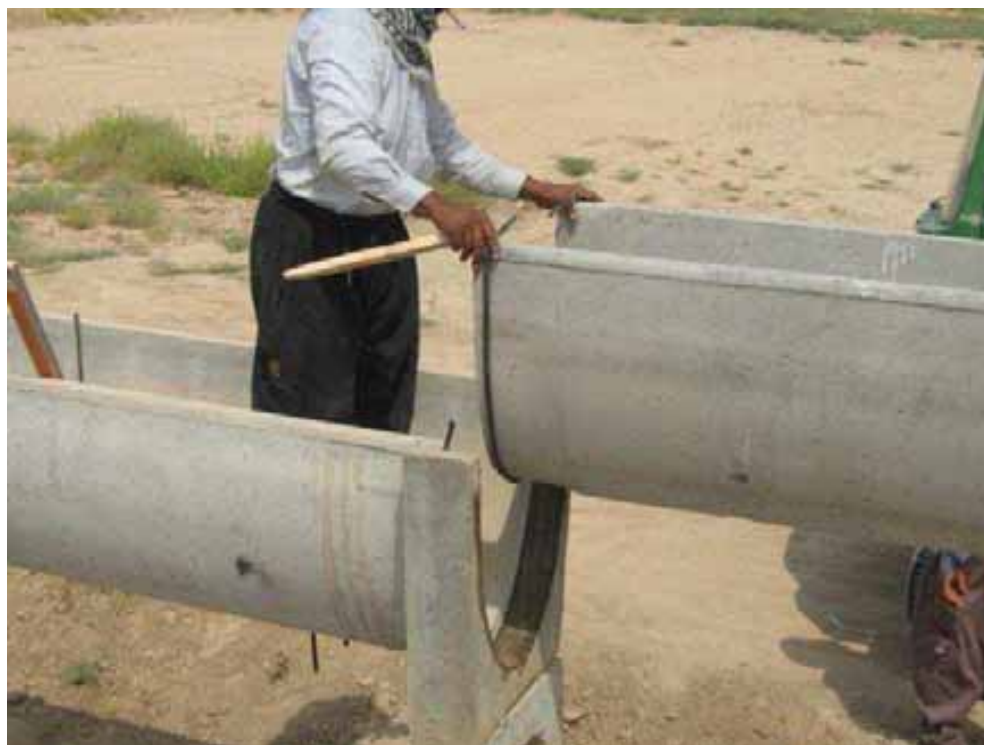
شکل (۵-۹): نصب نیم‌لوله بر روی زین
