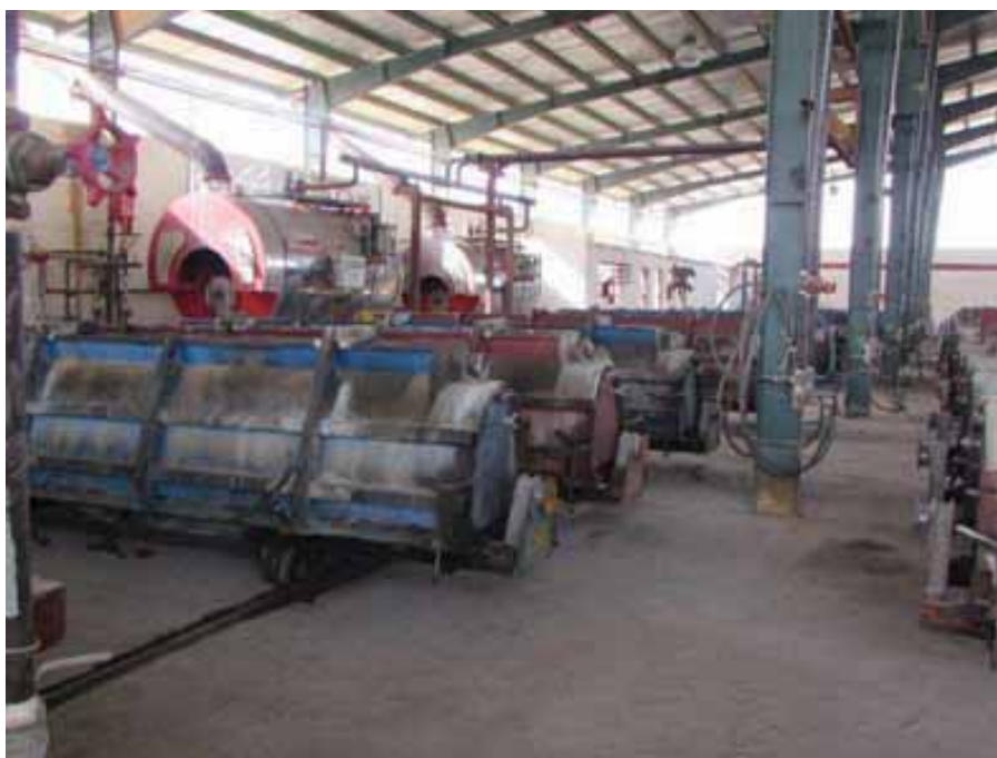
شکل (۳-۴): عمل آوری بتن با بخار آب
