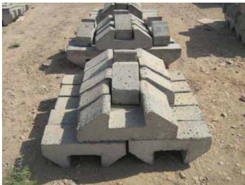
شکل (۳-۱۷): چیدمان کفشک‌های میانی جهت حمل با لیفتراک
