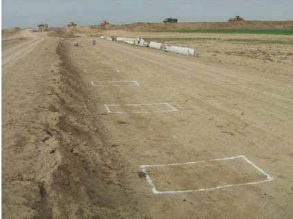
شکل (۵-۲): گچ‌ریزی جهت پی‌کنی محل نصب کفشک‌ها
