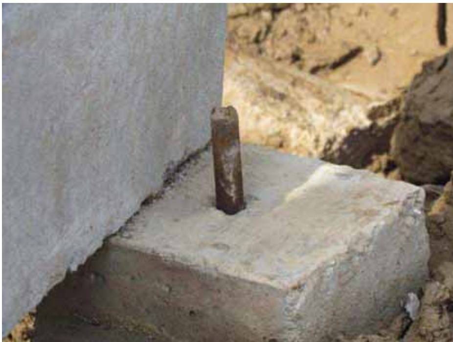
شکل (۵-۸): میلگرد اتصال زین به پایه
