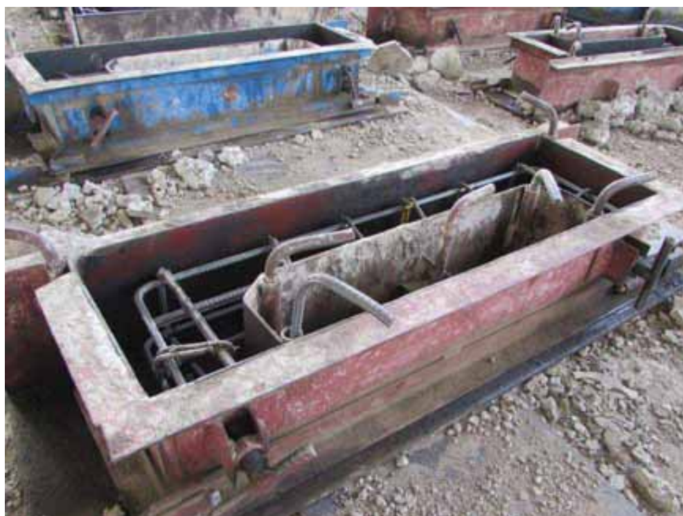
شکل (۳-۱۵): قالب و آرماتورگذاری پایه با ارتفاع ۲۵ سانتی‌متر
