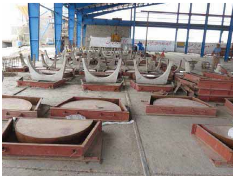
شکل (۳-۱۴): قالب ساخت و بتن‌ریزی زین‌ها
