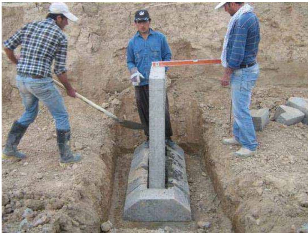
شکل (۵-۶): نصب پایه درون کفشک
