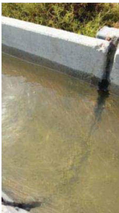
شکل (۵-۱۰): استفاده از ماستیک برای پر کردن محل اتصال کانالها
