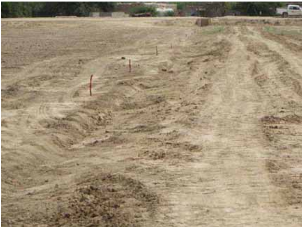
شکل (۵-۱): رگلاژ مسیر و پیکتاژ آن
