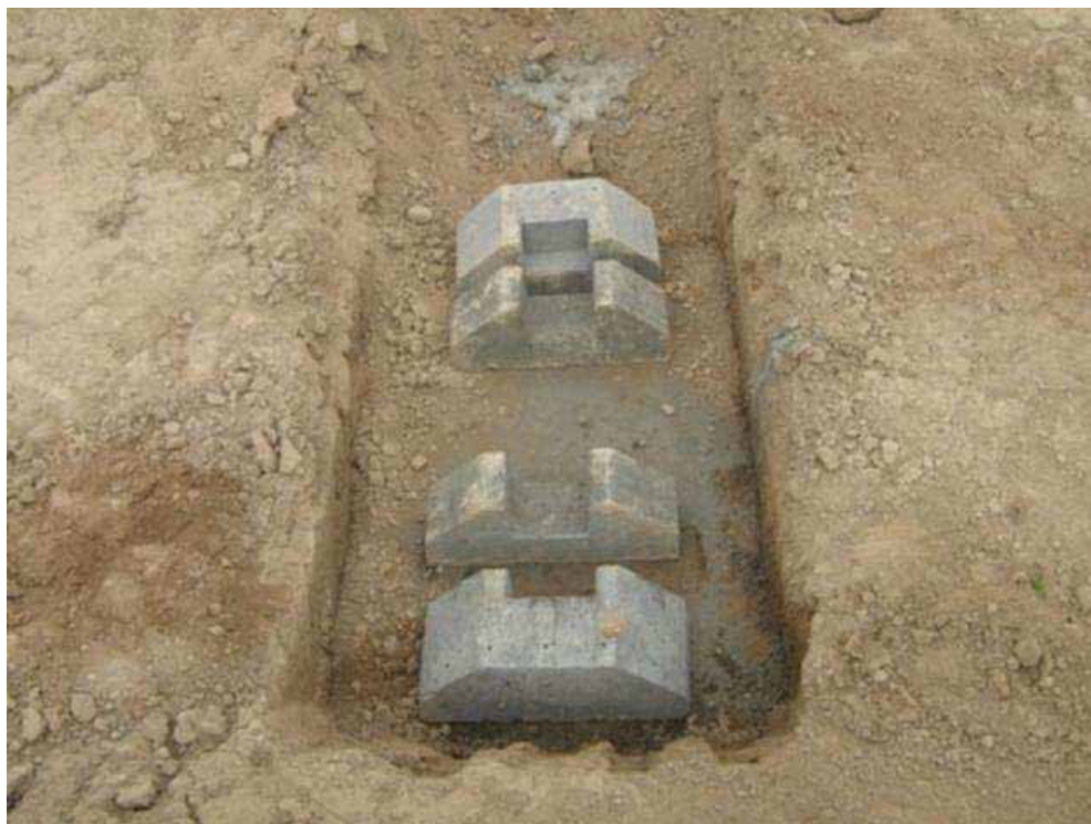
شکل (۵-۵): نصب کفشک
