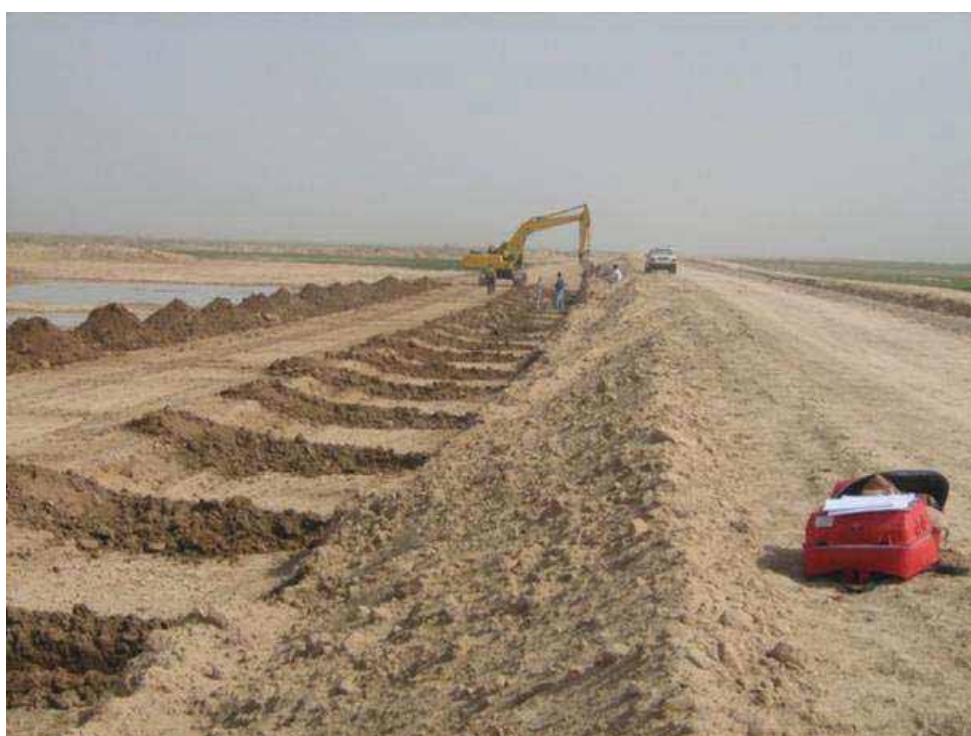
شکل (۳-۵): پی کنی محل با بیل مکانیکی
