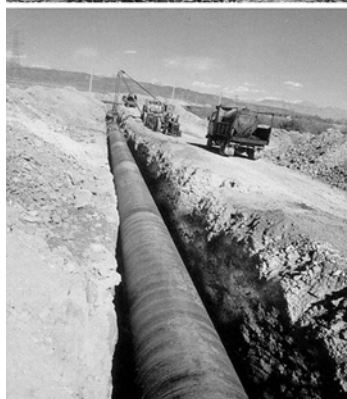
شکل شماره ۲۹- اجرای خط اصلی با لوله‌های فولادی ساخت کشور
