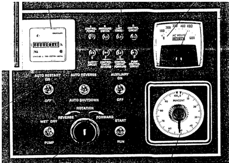
شکل شماره ۱۴- تابلو کنترل دستگاه دوار مرکزی تنظیم دستی (MANUAL)
