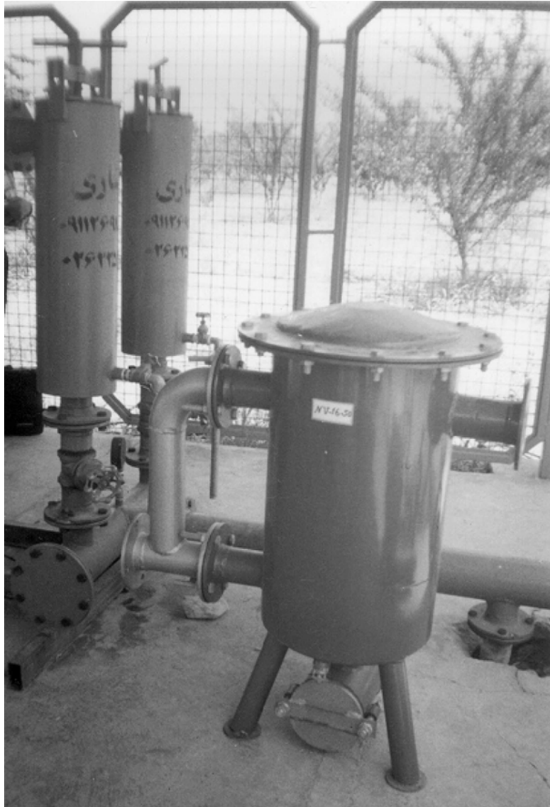
شکل شماره ۲۵ - فیلترهای توری در کنترل مرکزی آبیاری قطره‌ای سمت چپ نوع قدیمی معمول در ایران سمت راست نوع ابتکاری مدل NV16-50 ساخت مؤلف با قابلیت شستشوی معکوس و تخلیه اتوماتیک و جدا نمودن شن
