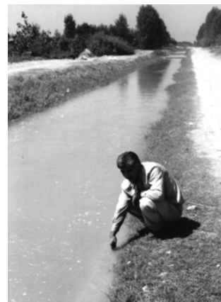
شکل ۱۵. تراز جریان چندین سانتی متر بالاتر از لبه‌های کانال قرار دارد
