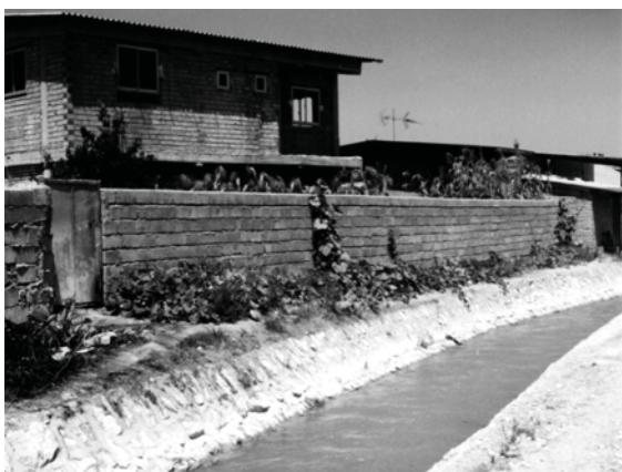
شکل ۱۳. احداث دیوار منازل و کشت در مجاورت دیواره کانال
