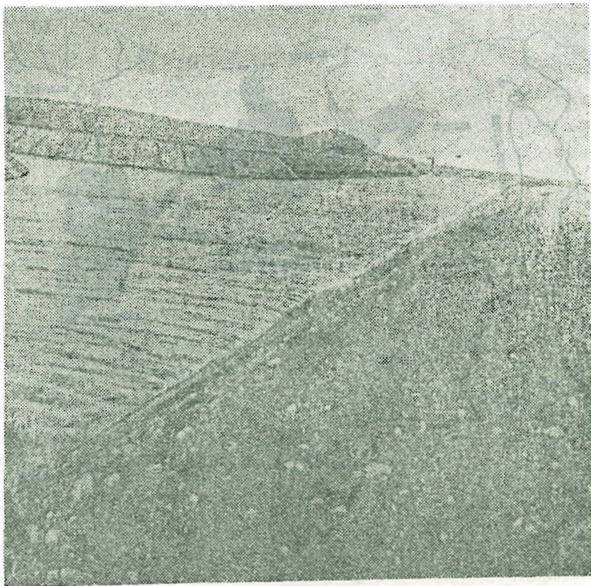
شکل ۲ شکاف در خاک زیر پوشش نشده موقت کانال کودیران
