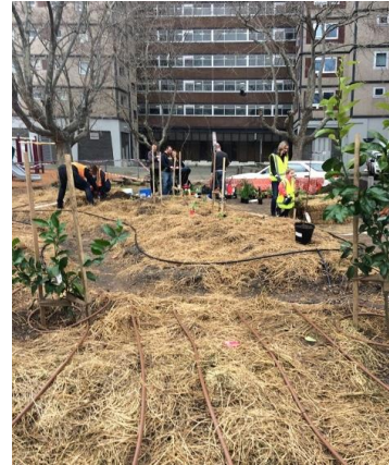
تصویر ۲- مالچ گیاهی و اجرای سیستم آبیاری
