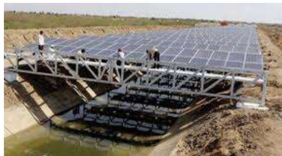
شکل ۳- ساخت و احداث سازه نگهدارنده پانل‌های خورشیدی در کانال بزرگ
