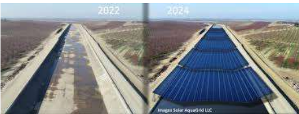
شکل ۲- کانال پوشش شده با عرض زیاد، قبل و پس از استقرار پانل‌های خورشیدی
