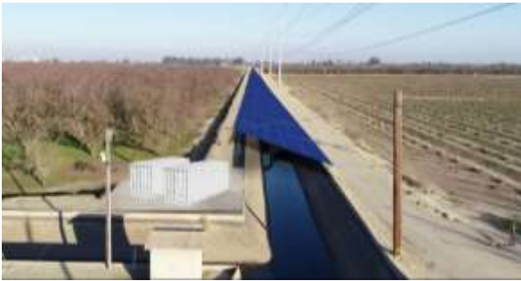
شکل ۱- کانال پوشش شده با عرض کم، مجهز به پانل خورشیدی و شبکه انتقال برق
