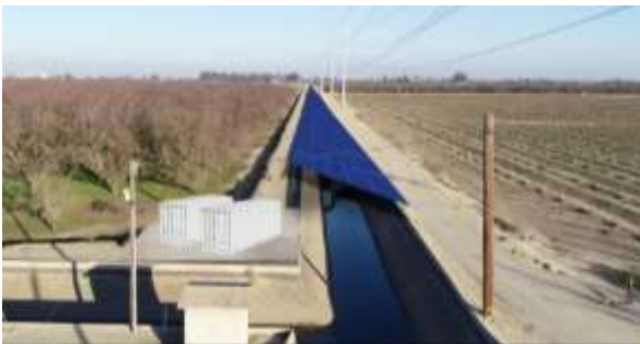
شکل ۱- کانال پوشش شده با عرض کم، مجهز به پانل خورشیدی و شبکه انتقال برق
