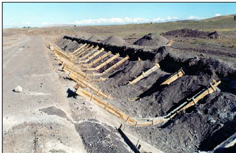
تصویر شماره (۵): قالب‌بندی جهت اجرای بالشتک‌های بتنی
