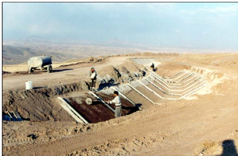
تصویر شماره (۱۶): آپاشی و تراکم مصالح فیلتربا غلطک دستی
