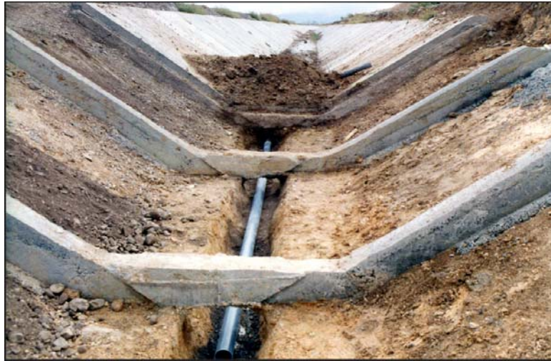
تصویر شماره (۱۴): کارگذاری لوله P.V.C مشبک در زیر بالشتک‌های بتنی و مقطع فیلترریزی
