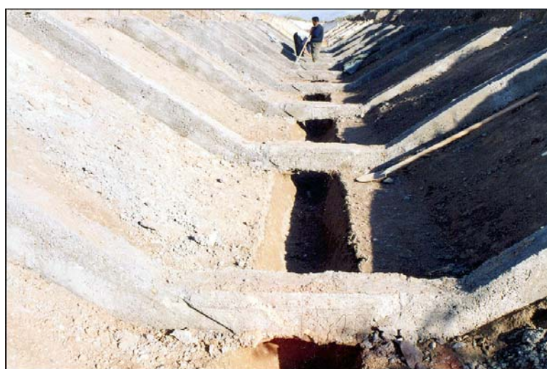
تصویر شماره (۱۳): مقطع کنی و آماده سازی محل قرارگیری لوله P.V.C مشبک زهکش
