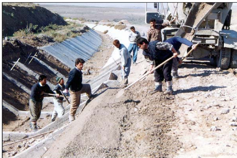
تصویر شماره (۱۱): اجرای شفته سیمانی در محل سرشیب‌ها، بالادست بالشتک‌های بتنی
