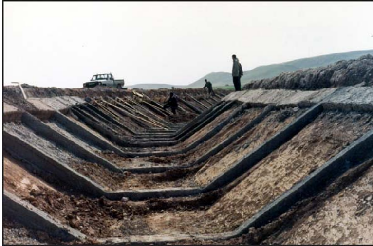
تصویر شماره (۸): بالشتک‌های بتنی اجرا شده قبل از اجرای شفته سیمانی و فیلتر ریزی
