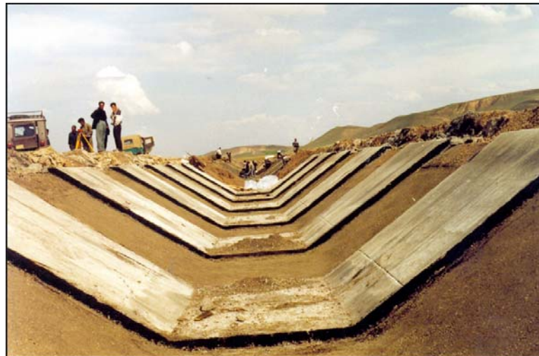
تصویر شماره (۲۰): اجرای یک در میان پانلهای بتنی روی مصالح فیلتر
