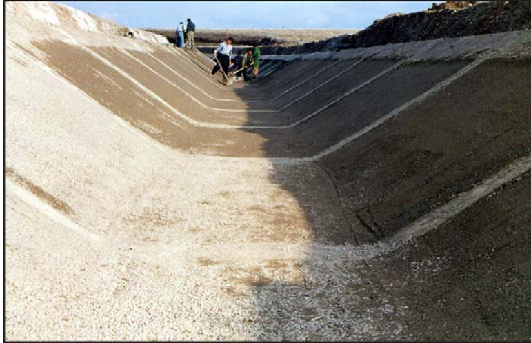
تصویر شماره (۱۷): فیلترریزی و غلطک زنی درحد واسط بالشتک‌های بتنی و آمادگی بستر جهت اجرای لاینینگ
