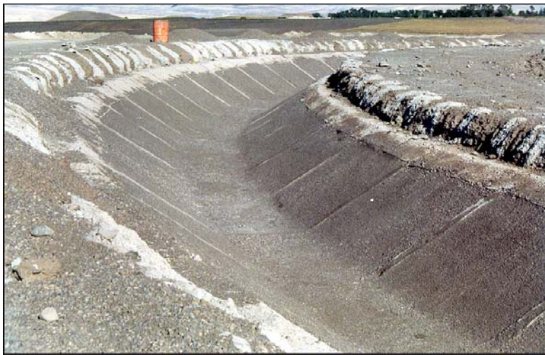
تصویر شماره (۱۸): نمایی از سطح آماده شده سیستم فیلتر، زهکش در زیر پوشش کانال (قبل از اجرای لاینینگ)
