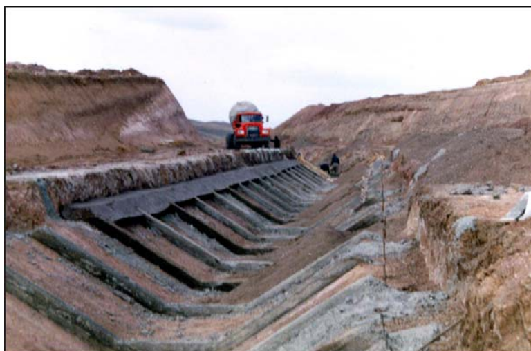
تصویر شماره (۱۲): نمایی از بالشتک‌ها و شفته سیمانی اجرا شده قبل از فیلترریزی
