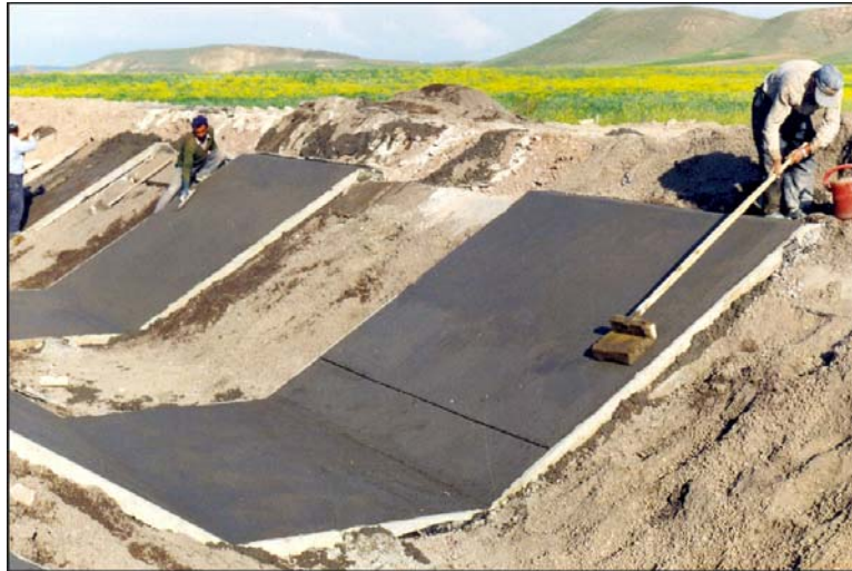
تصویر شماره (۲۱): پرداخت بتن (لاینینگ) روی مصالح فیلتر و بالشتک‌های بتنی
