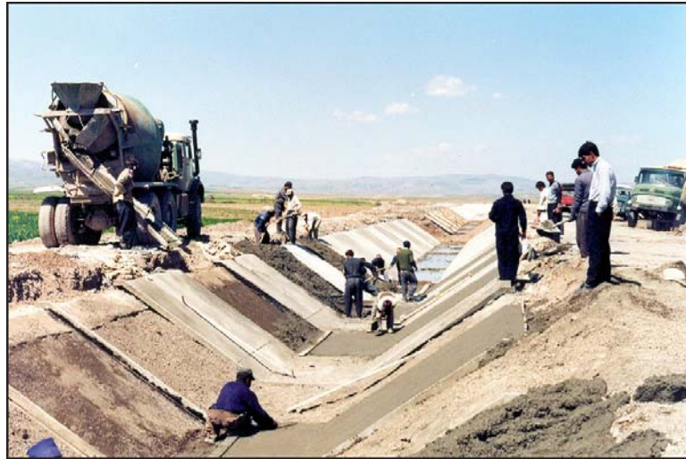
تصویر شماره (۱۹): اجرای بتن پوشش کانال روی مصالح فیلتر
