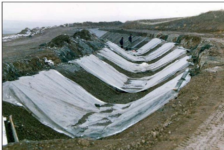
تصویر شماره (۲۲): حفاظت و نگهداری از لاینینگ اجرا شده در نواحی فیلترریزی
