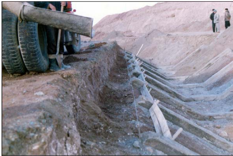
تصویر شماره (۹): آماده سازی و قالب‌بندی جهت اجرای شفته سیمانی در بالادست بالشتک‌های بتنی
