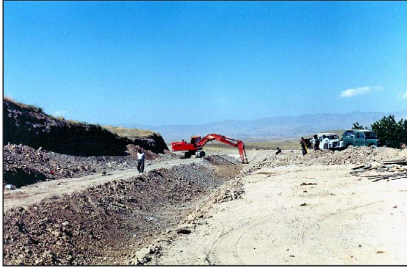
تصویر شماره (۳): کانال‌کنی مسیر در نواحی لازم به اجرای فیلتر و زهکش
