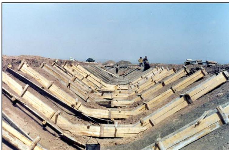
تصویر شماره (۶): قالب‌بندی بالشتک‌های بتن زیر لاینینگ
