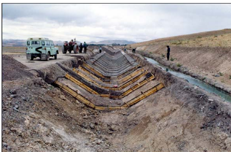
تصویر شماره (۷): بتن‌ریزی بالشتک‌های بتن زیر لاینینگ و نمایی از بالشتک‌های اجرا شده در طول مسیر
