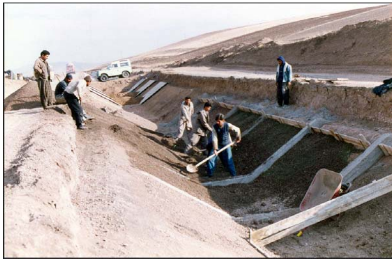
تصویر شماره (۱۵): فیلترریزی و پخش مصالح در حد واسط بالشتک‌های بتنی
