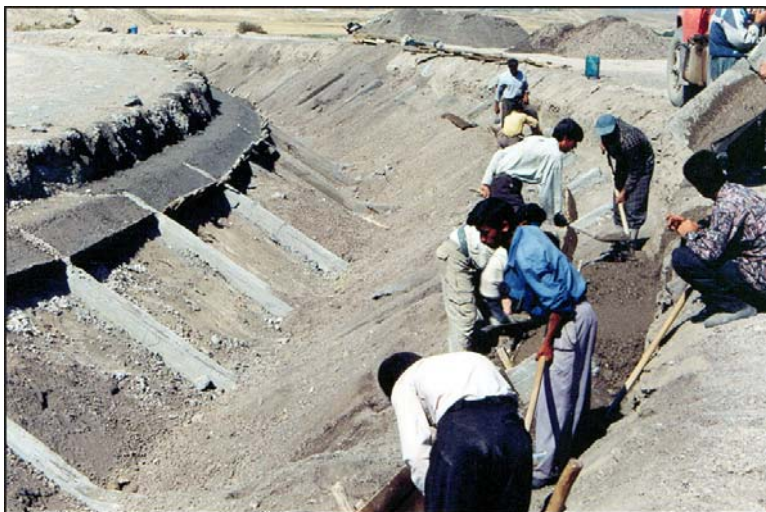
تصویر شماره (۱۰): اجرای شفته سیمانی در بالادست بالشتک‌های بتنی (قبل از فیلتر ریزی)
