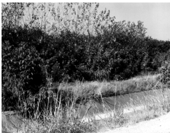
شکل ۱۱. وجود پوشش گیاهی نسبتاً انبوه در مجاورت و روی کانال‌های شبکه
