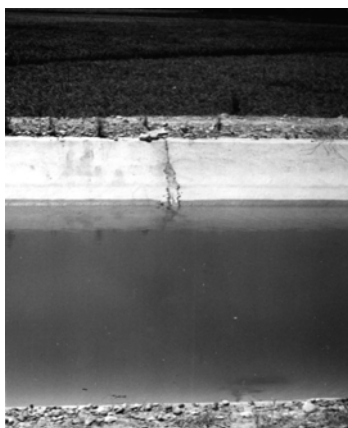
شکل ۱۰. بستن درزهای انبساط
