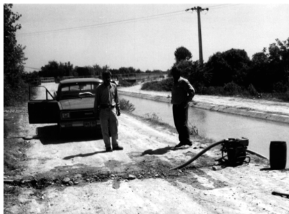
شکل ۵. تخریب جاده دسترسی در اثر برداشت غیرمجاز از کانال اصلی با موتورپمپ
