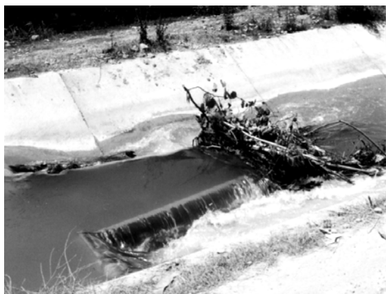
شکل ۱۶. گرفتگی چک بر اثر ریختن آشغال در کانال اصلی
