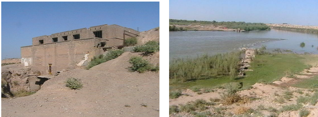
تصویر شماره ۱- تونل آب بر و ایستگاه پمپاژ کرخه
