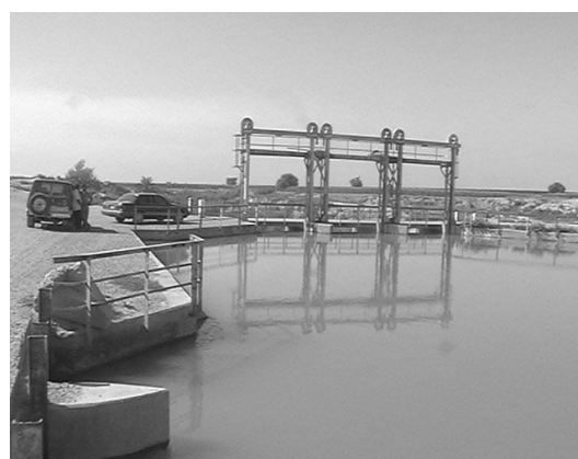
نمای بالادست سد انحرافی و آبگیر کانال انتقال
