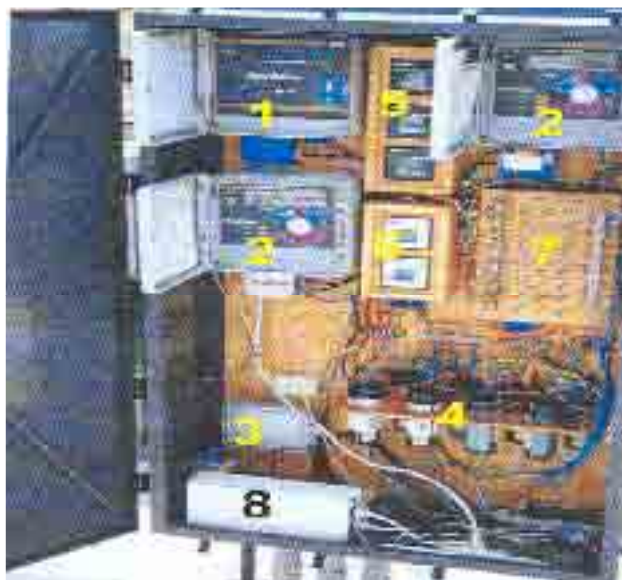
شکل ۱۷: تابلو مرکزی کنترل اتوماتیک در روش آبیاری قطره ای
