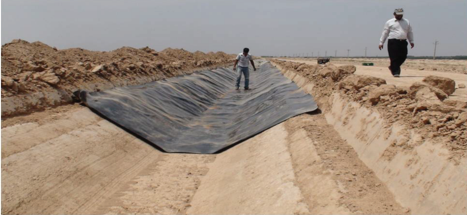
Fig. 5. HDPE installation in Arayez Irrigation and drainage network (l'installation d'HDPE dans parties du parcours du canal dans Arayez et réseau de drainage)
