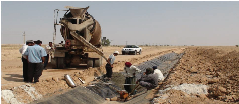
Fig. 6. A view of the HDPE installation in some parts of canal paths in Arayez Irrigation and drainage network (Une vue de l'installation HDPE dans certaines parties du parcours du canal d'irrigation dans Arayez et réseau de drainage)
