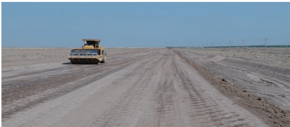
Fig. 4. A view of the soil changing in Arayez Irrigation and drainage network (Une vue du sol en changeant Arayez irrigation et du réseau de drainage)
