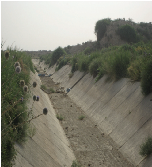
Fig. 2. Dand bags in canal (Sacs de sable dans le canal d'irrigation)
